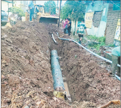
सड़क किनारे चल रहा पाइप लाइन विस्तार कार्य
